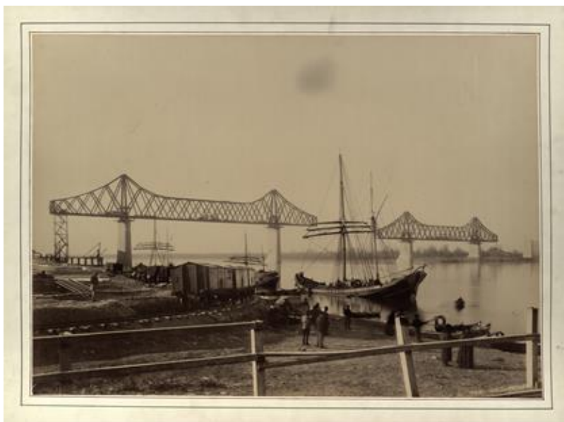
Fig. 2, Fotografie, Podul peste Dunăre în construcție, Biblioteca Academiei Române, Cabinetul de Stampe.
