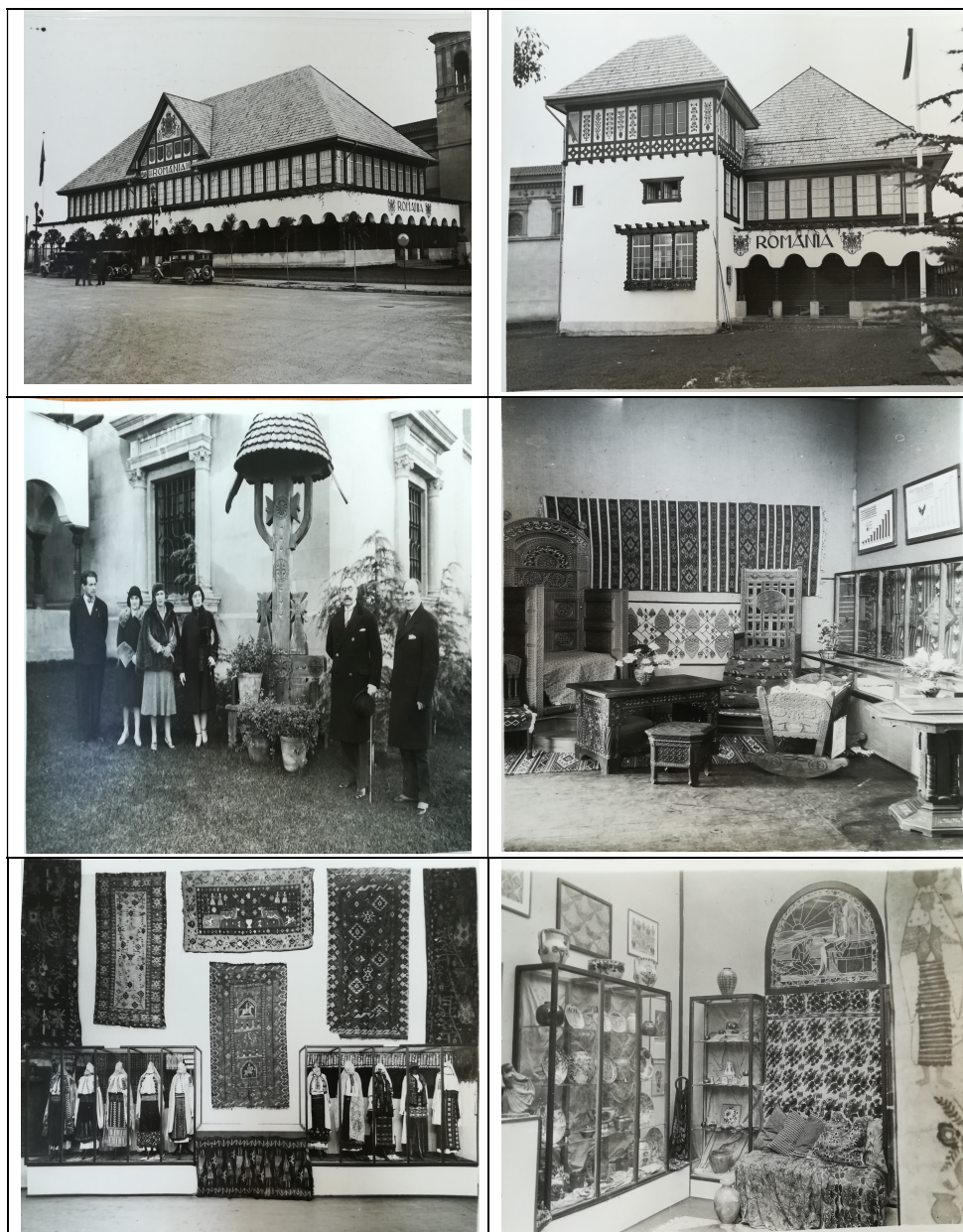
Fig. 1-6, Pavilionul României la Expoziția Internațională de la Barcelona, 1929, Biblioteca Academiei Române, Arhiva Alexandru Tzigara-Samurcaș.
